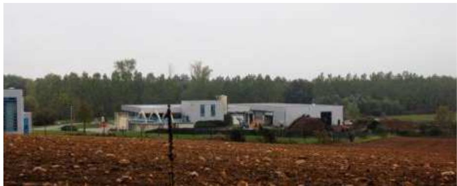
Station d'épuration de Traffeyère
